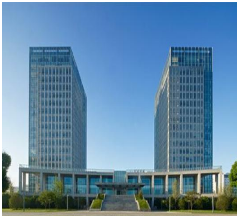
泗阳县市民中心双子楼总建筑面积 5.8 万 m^2 ，为 75 米高 19 层，投资约 2.8 亿。(结算审计)
